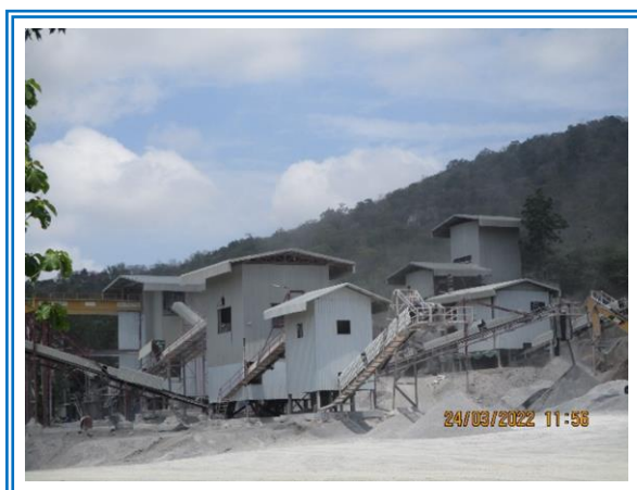
รูปที่ 3-12 อาคารโรงโม่หินแบบปิดคลุม
